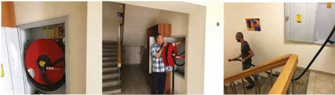
სურათი 16.2. სსიპ სოფლის მეურნეობის სახელმწიფო ლაბორატორიაში ხანძარსაწინააღმდეგო სისტემების შემოწმება
